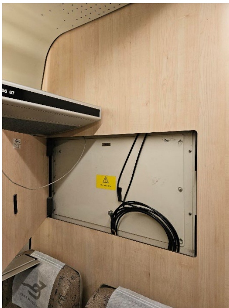
Figur 4 Antennkablage tåg mot takantenn
